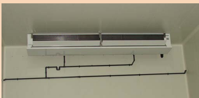
Dzesēšanas iekārtas iztvaikotāji augļu noliktavā ir ar lielāku lameļu virsmu, lai samazinātu mitruma zudumus, ledum sasalstot uz iztvaikotāja
